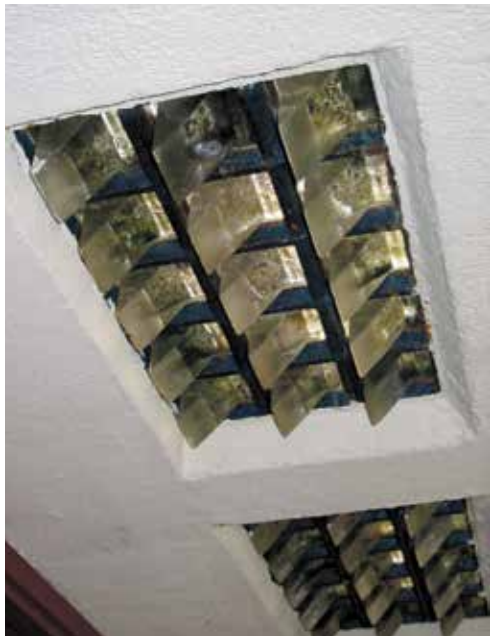
De betonluifel van café De Paap heeft glazen prismaas die het invallend daglicht naar binnen-kaatsen: uniek detail
